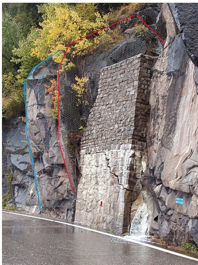
Figura 2: il muro con la traccia della rottura trasversale e i due volumi rocciosi oggetto di demolizione
